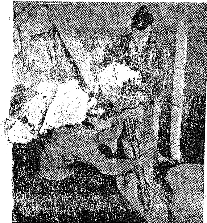
(شكل ٢٣) استخراج شريجه زجاجيه مدخنه من أسطوانة غطست . د . ٤٠ قدما تحت سطح البحر لتسجيل درجة حرارة مياه البحر
